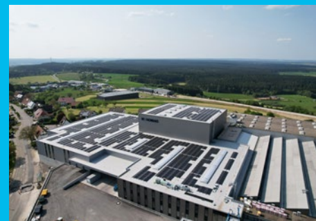
Photovoltaikanlage in Schopfloch
